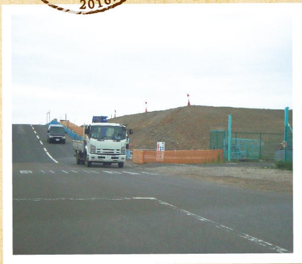
かさ上げ工事がすすむ名取市関上地区(2016年7月)
