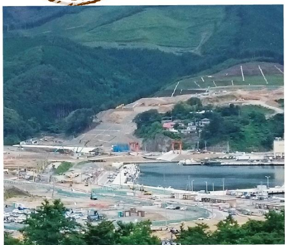
山を切り開いての造成工事がすすむ女川町(2016年7月)
