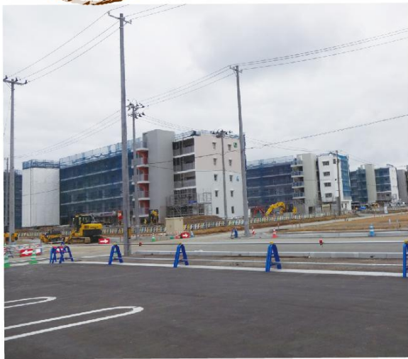
気仙沼市鹿折地区の災害公営住宅(2016年6月)
