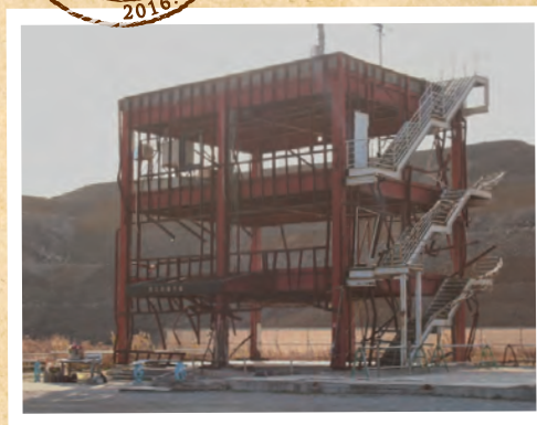
骨組となった旧防災庁舎。奥は用意されている造成用の土砂。
