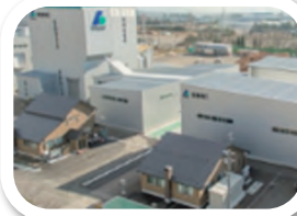
バイオマス発電所 計40MW （平川市・大仙市・花巻市・田村市・野田村）
