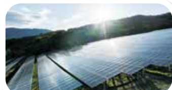
コープいわき太陽光発電 (2024年度稼働予定)
