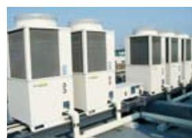
最適制御システム・マルチ式インバーター冷凍機
